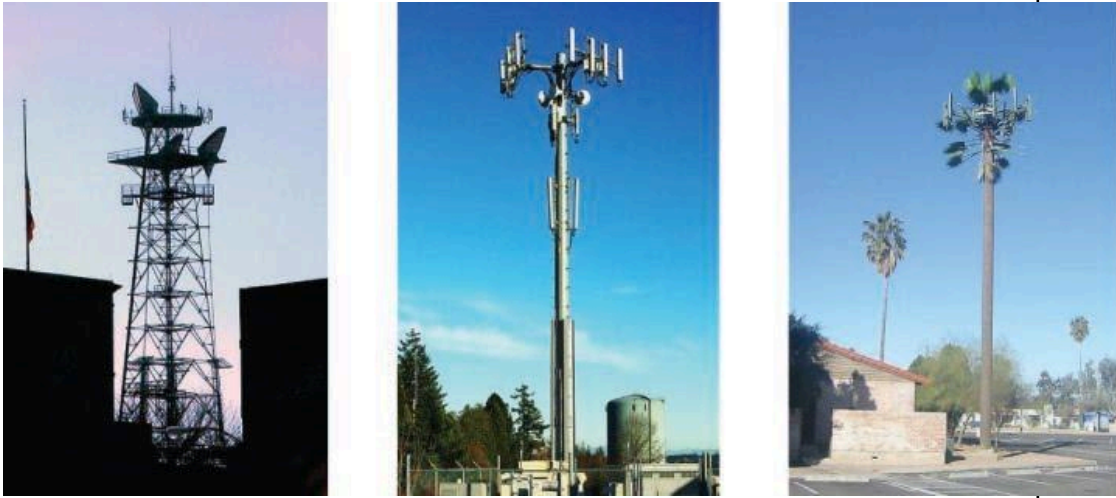
Figure 8.1.3. Les tours radio et cellulaires sont généralement utilisées pour transmettre des rayonnements électromagnétiques de grande longueur d'onde. De plus en plus, les tours cellulaires sont conçues pour se fondre dans le paysage, comme la tour cellulaire de Tucson, Arizona (à droite) déguisée en palmier (crédit à gauche : modification de l'œuvre de Sir Mildred Pierce ; crédit au milieu : modification de l'œuvre de M.O. Stevens).
